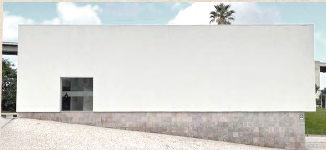
Salão Paroquial da Igreja da Nossa Senhora dos Navegantes
